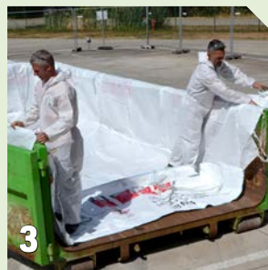
Plaats de containerzak in de container en plooi de zakken open.
