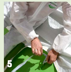
Bevestig de zak met de linten aan de zijkant van de container.
