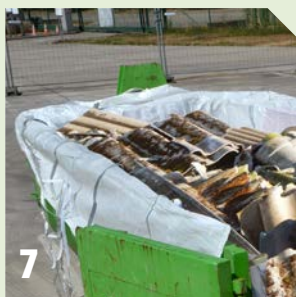
Deponeer het hechtgebonden asbest in de container met containerzak. Let op dat je de platen niet breekt.
