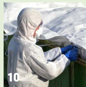
Wanneer de zak vol is of de werken zijn uitgevoerd, de flappen dichtvouwen en sluiten. Eventueel kan je nog eens benevelen voor het dichtmaken.
