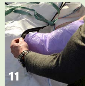
Steek je persoonlijke beschermingsmiddelen, de gebruikte plastic folie en de poetsdoeken in twee plastic zakken en deponeer ze in de container.
